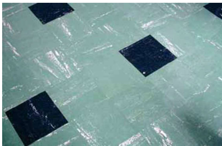
Figura 11 - pavimento in vinil-amianto
