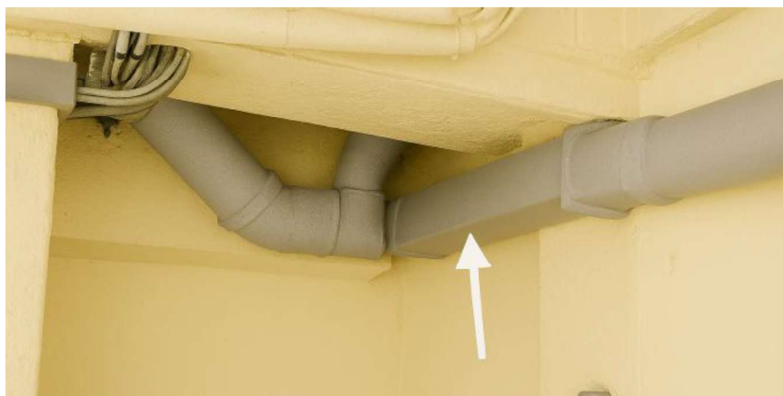
Figura 10 - canali di ventilazione in cemento-amianto
