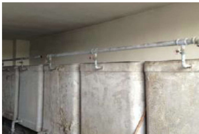
Figure 30 - tettoia in cemento amianto in discreto stato di conservazione (sx); cassoni per l'acqua in cemento amianto in buono stato di conservazione (dx) (fonte: Inail, Conoscere il rischio/polveri e fibre/amianto)
