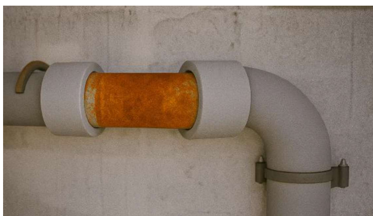
Figura 9 - condutture in cemento-amianto
