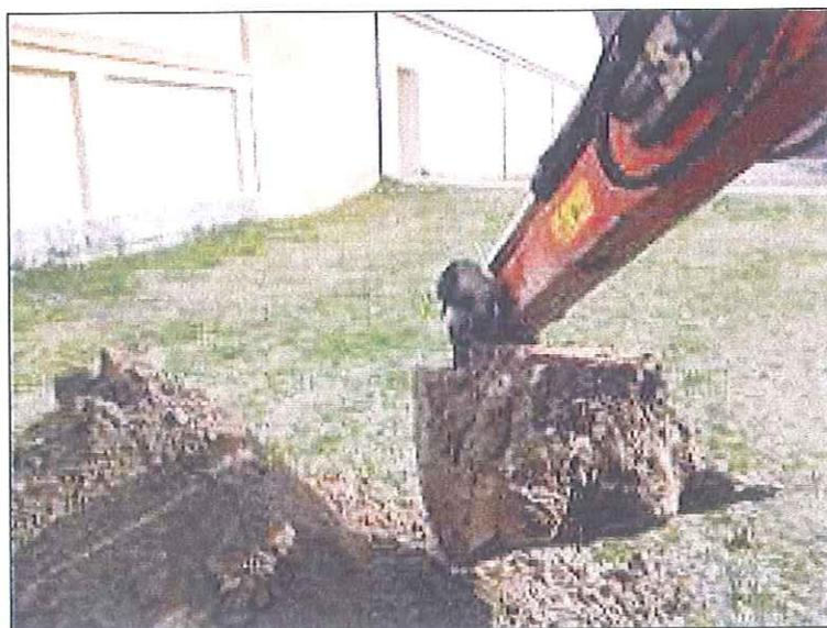
*Particolare del pozzetto esplorativo*
